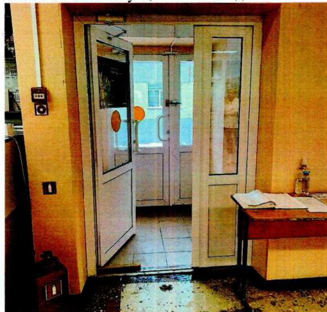
ФОТО № 35 Эвакуационный выход
