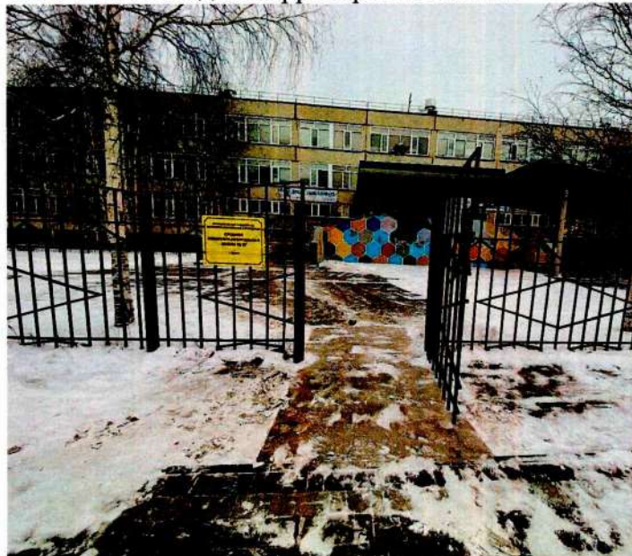
ФОТО № 1 Вход на территорию. Калитка
