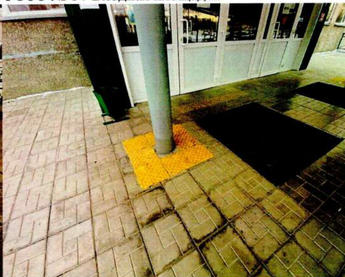
ФОТО № 14 Входная площадка
