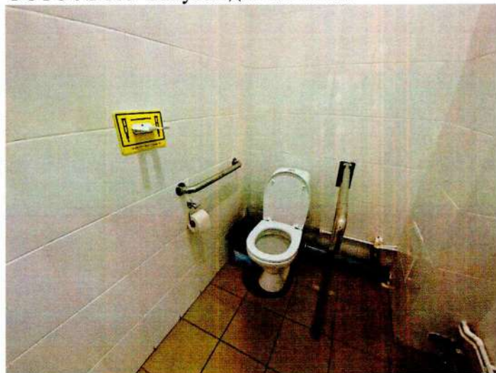
ФОТО № 105 Санузел для МГН №1
