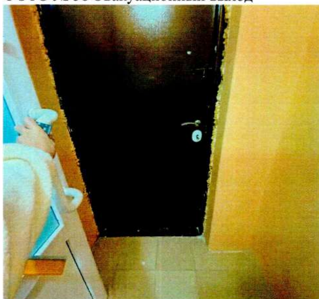
ФОТО № 58 Эвакуационный выход
