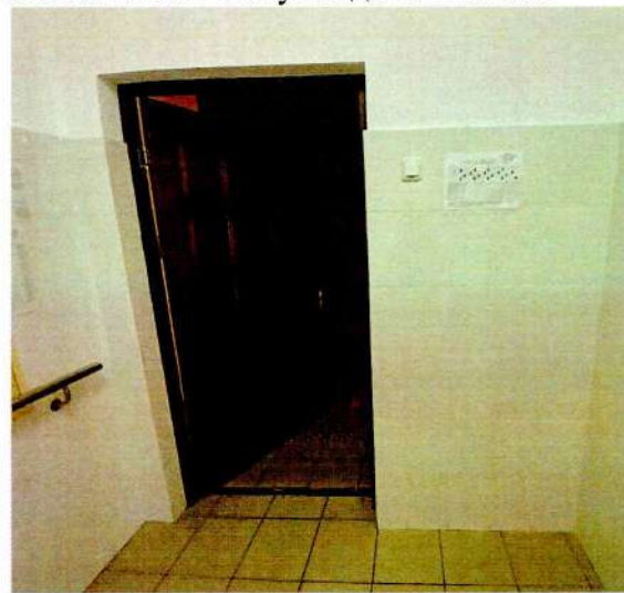
ФОТО № 112 Санузел для МГН №2
