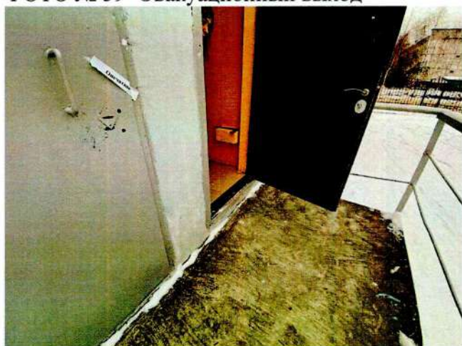
ФОТО № 59 Эвакуационный выход
