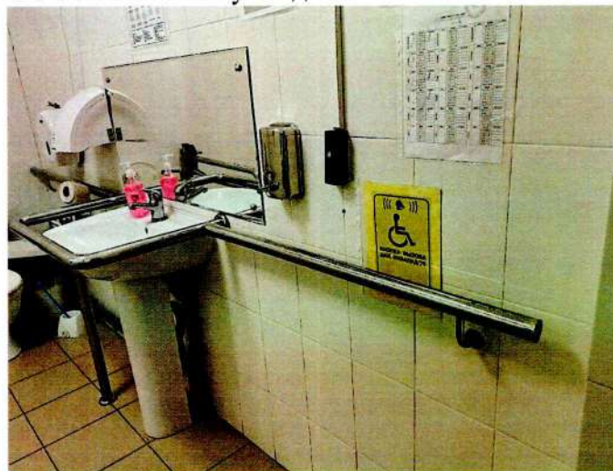
ФОТО № 110 Санузел для МГН №2
