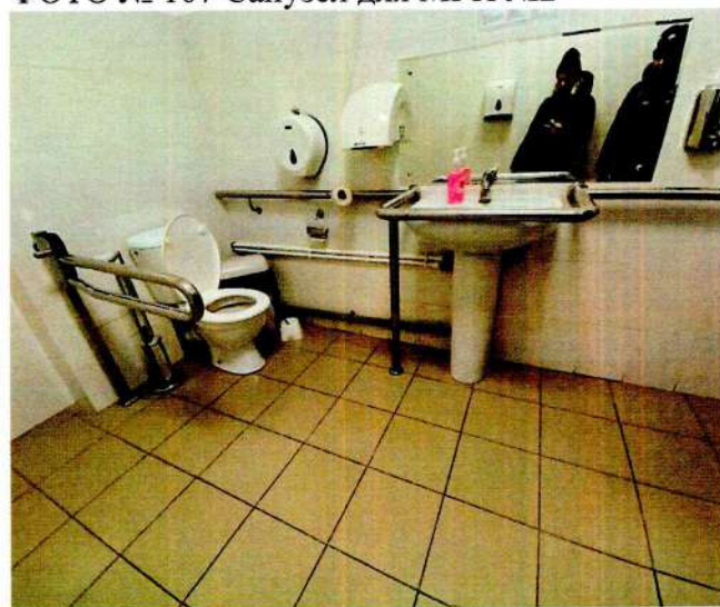
ФОТО № 107 Санузел для МГН №2
