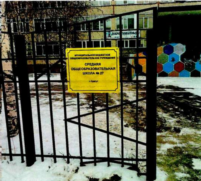
ФОТО №2 Вход на территорию. Калитка
