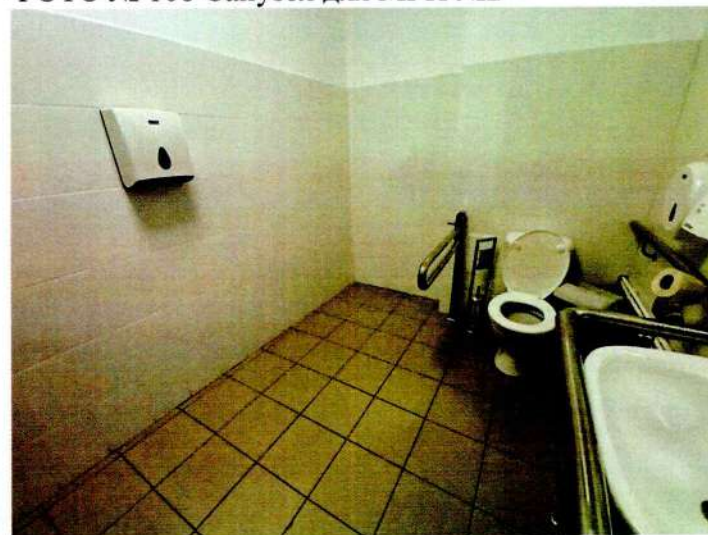
ФОТО № 108 Санузел для МГН №2
