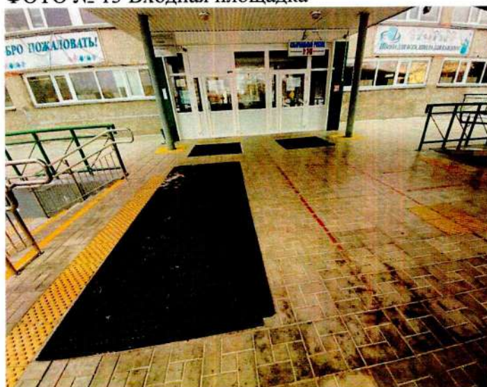
ФОТО № 13 Входная площадка
