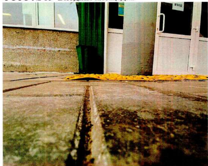
ФОТО № 15 Входная площадка
