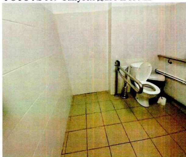
ФОТО № 109 Санузел для МГН №2
