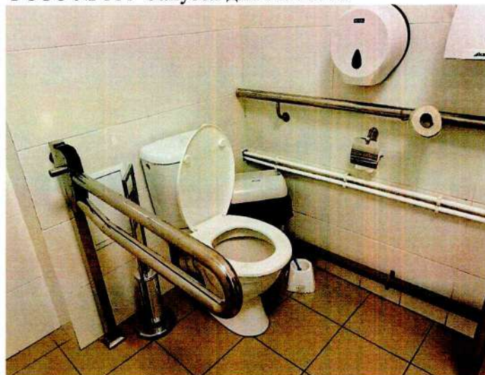
ФОТО № 111 Санузел для МГН №2
