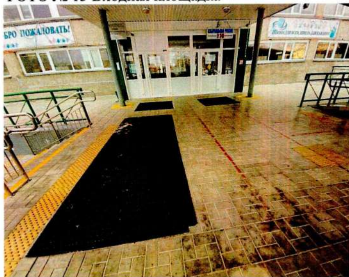
ФОТО № 13 Входная площадка
