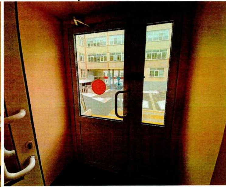
ФОТО № 36 Эвакуационный выход
