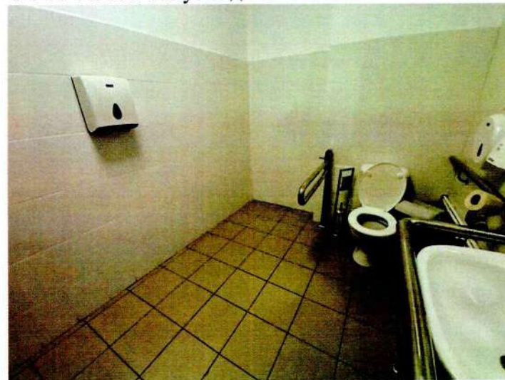
ФОТО № 108 Санузел для МГН №2
