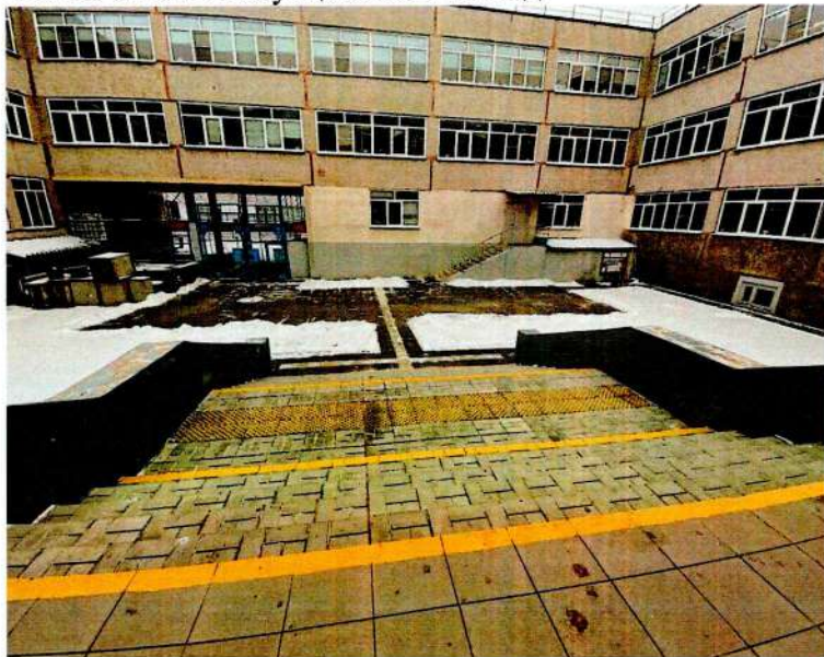
ФОТО № 37 Эвакуационный выход
