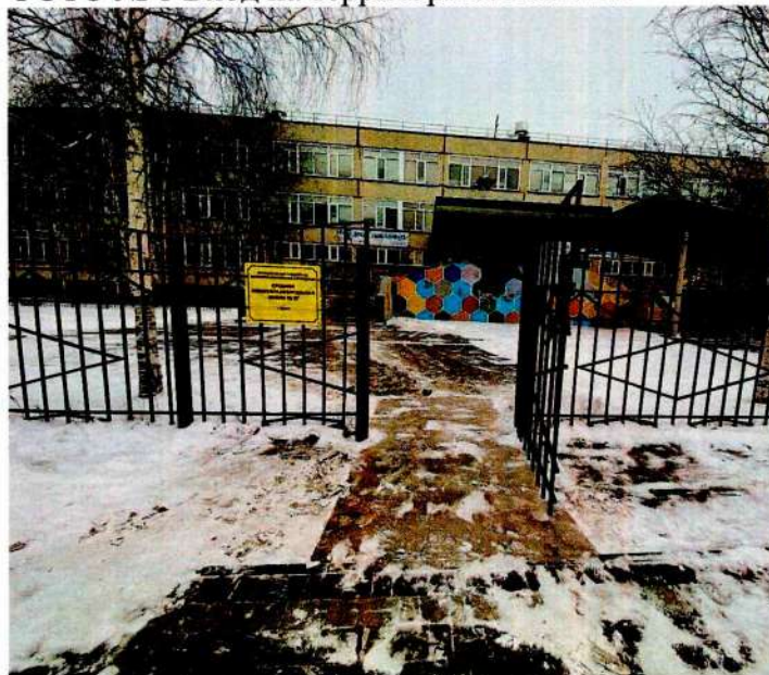
ФОТО № 1 Вход на территорию. Калитка
