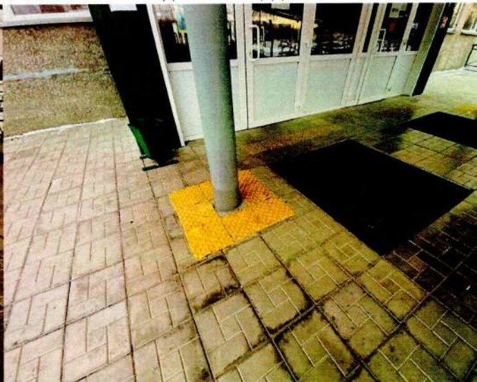
ФОТО № 14 Входная площадка
