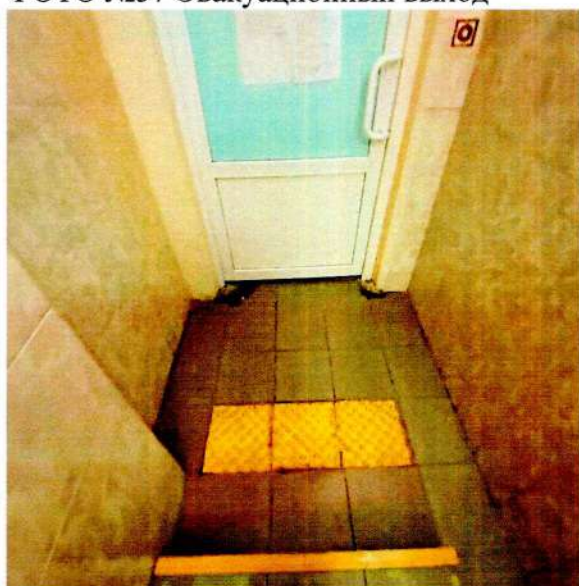
ФОТО №57 Эвакуационный выход
