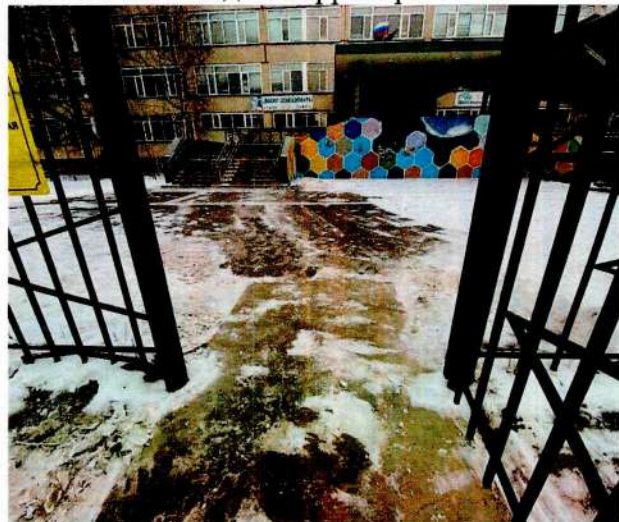
ФОТО № 3 Вход на территорию. Калитка
